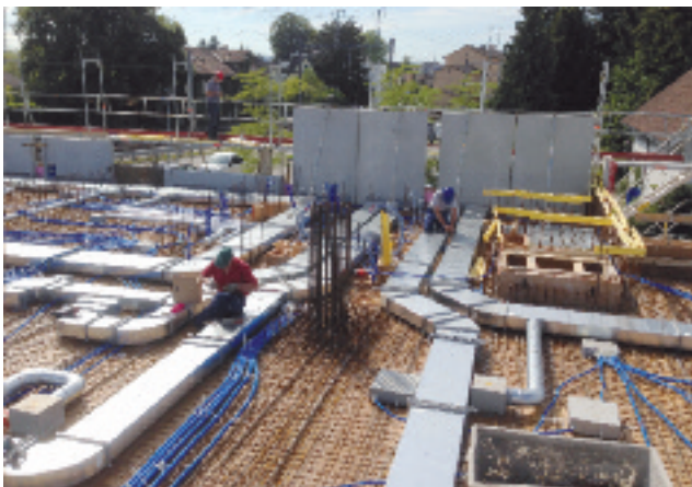
Lüftung und Elektrisch werden für die Betonierung vorbereitet
