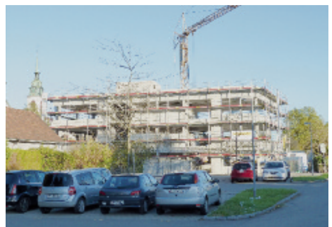
Ende Oktober 2013 steht der Rohbau
