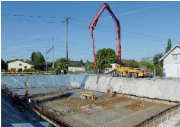
Bodenplatte und Baugrubensicherung
